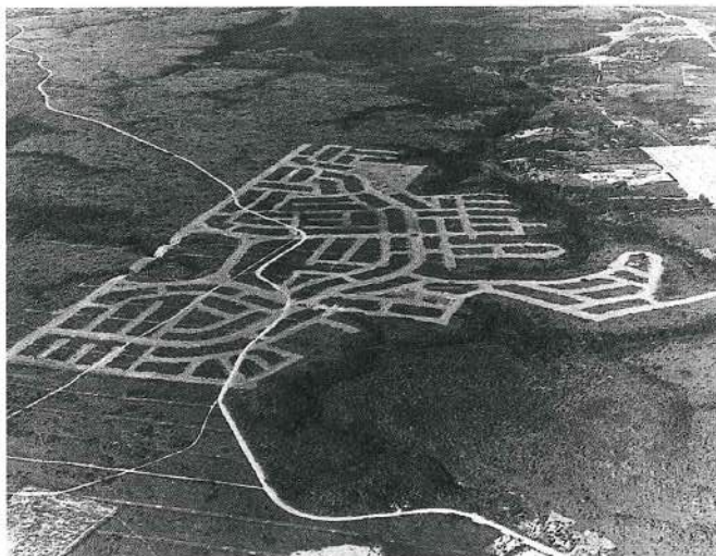
ABERTURA DE RUAS - PARQUE RESIDENCIAL LARANJEIRAS - 1975
