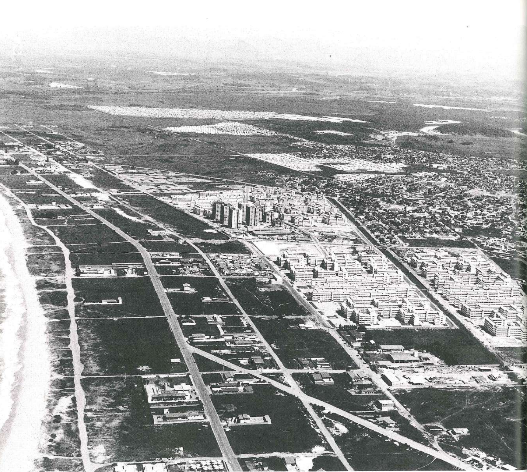
PRAIA DE ITAPARICA, VILA VELHA - DÉCADA DE 80 - OBRAS DO PARQUE COQUEIRAL DE ITAPARICA - AO FUNDO OS CONJUNTOS ILHA DOS BENTOS, GUARANHUNS E ARAÇÁS
