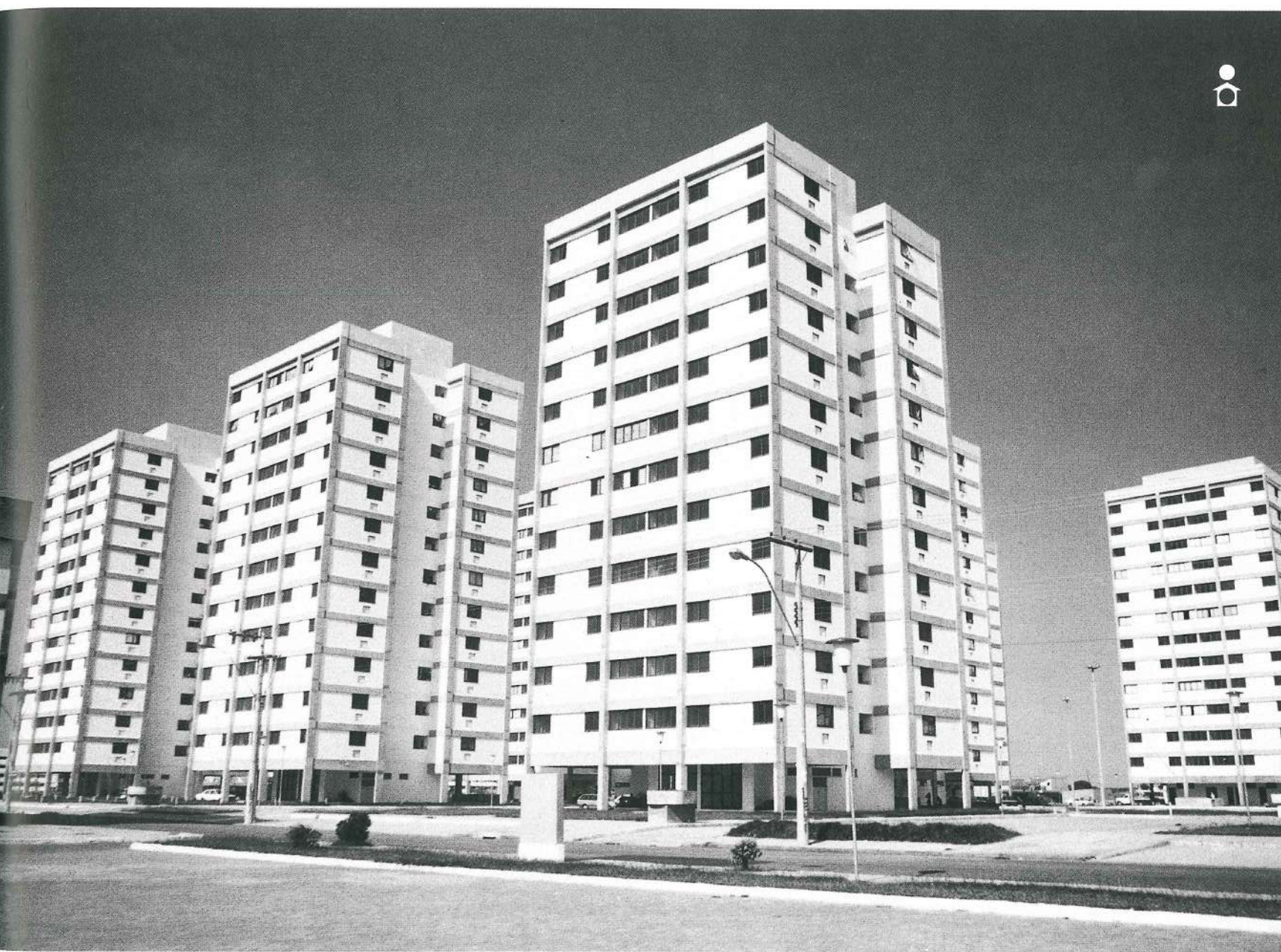
PARQUE COQUEIRAL DE ITAPARICA - PRÉDIOS H-12
