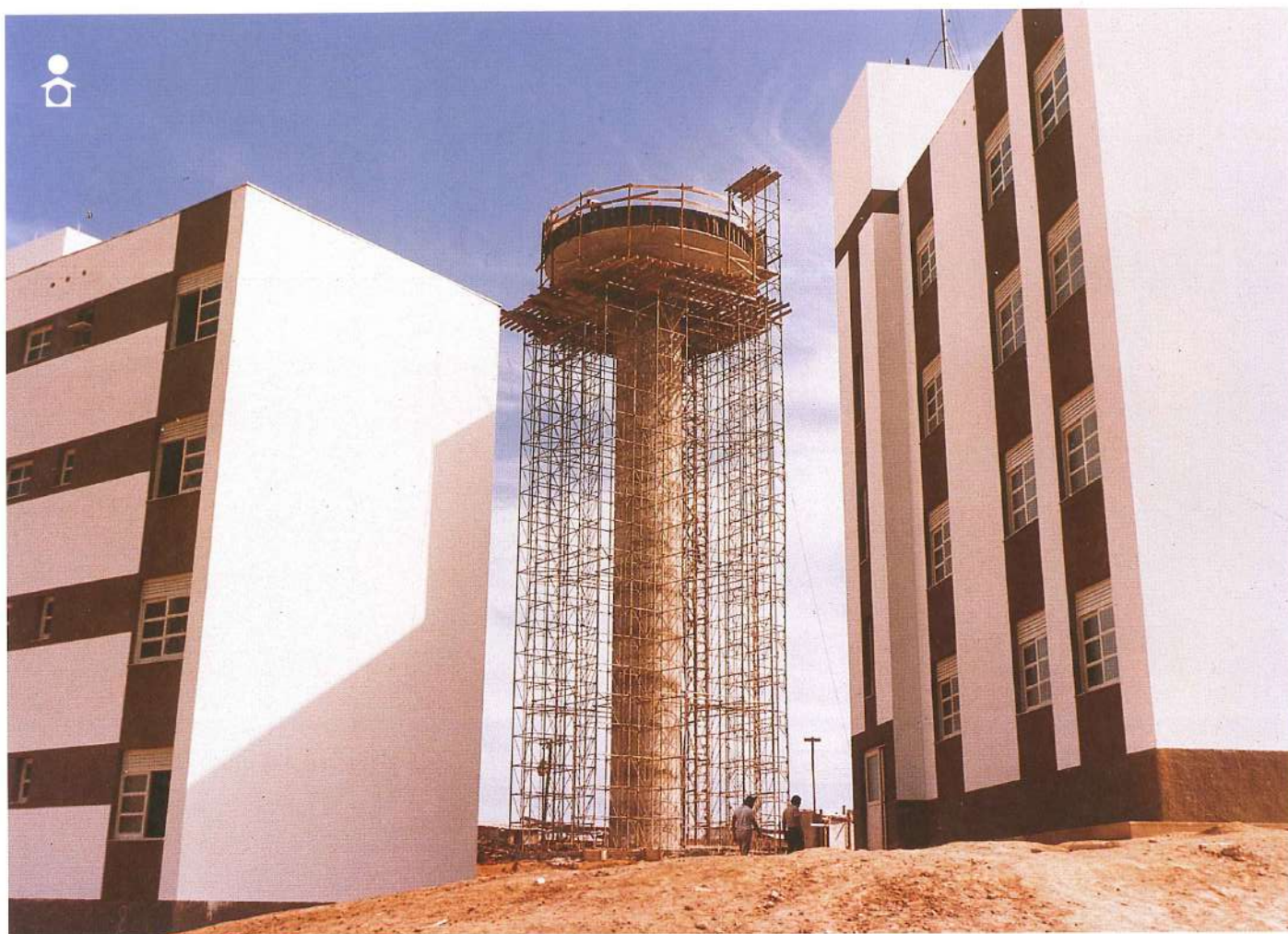
PRÉDIOS EM JACARAÍPE - SERRA - CONSTRUÇÃO DO CASTELO DE ÁGUA
